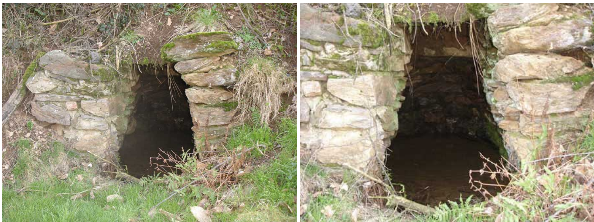
L'ouverture est de 1 m de haut sur 0,50 m de large, bien protégée de toute pollution
