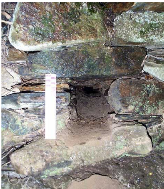
Le trop plein du bief
