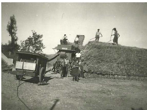
A la fin de la guerre, il manquait du carburant pour faire marcher le tracteur. On faisait tourner la batteuse avec un gros moteur électrique.
