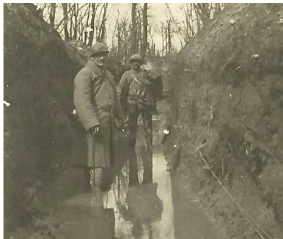
Tranchées sous la pluie
