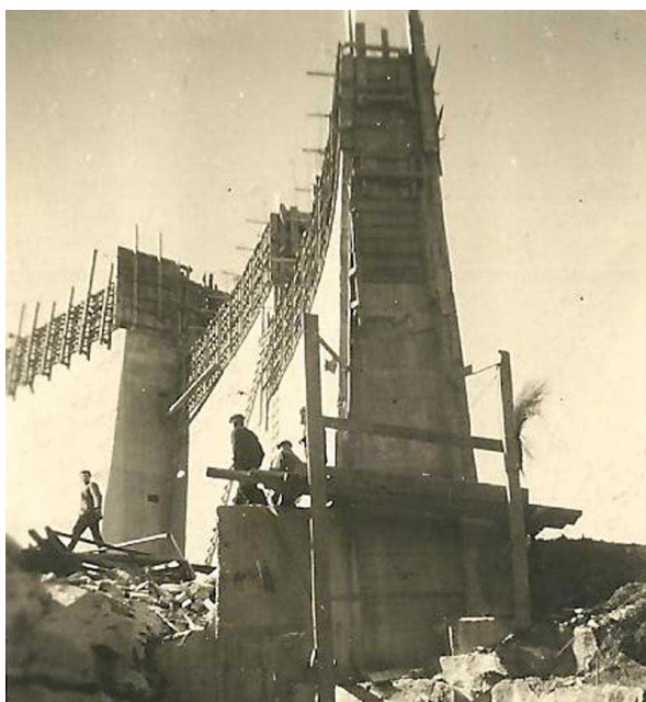
La route en construction (photo A. Roumegoux)
