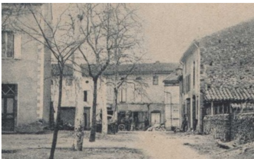
Au fond sur l'avenue d'Alban, la maison de Vèzes armurier sur la gauche, et la maison de Vieu forgeron sur la droite (photo avant 1910). La mairie qu'on voit sur la gauche au 1 er plan n'existait pas en 1850.
