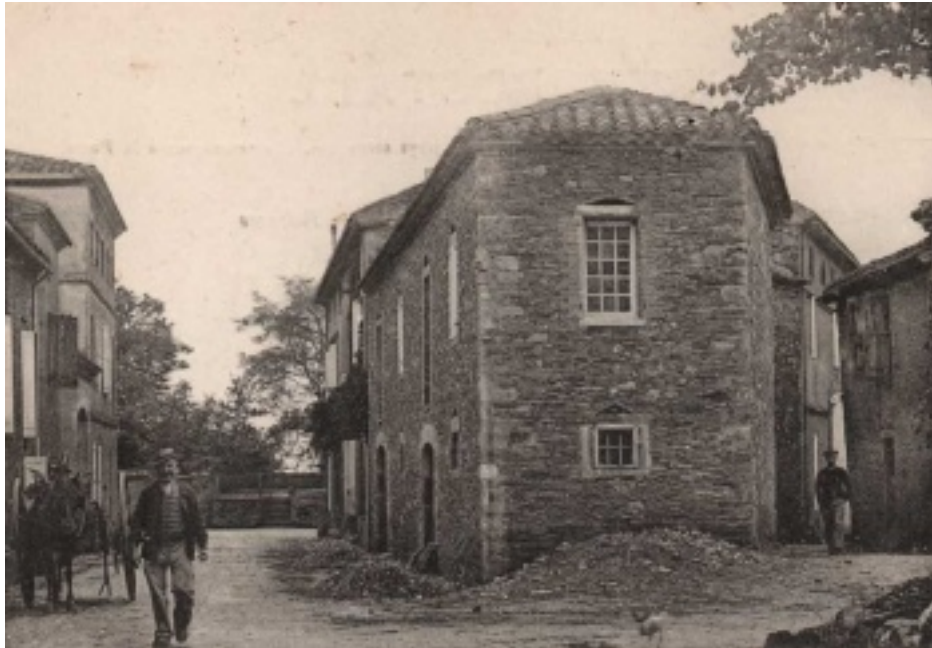
On aperçoit une partie de l'auberge de François Vèzes tout à droite (photo avant 1906). Ce bâtiment est aujourd'hui démol
