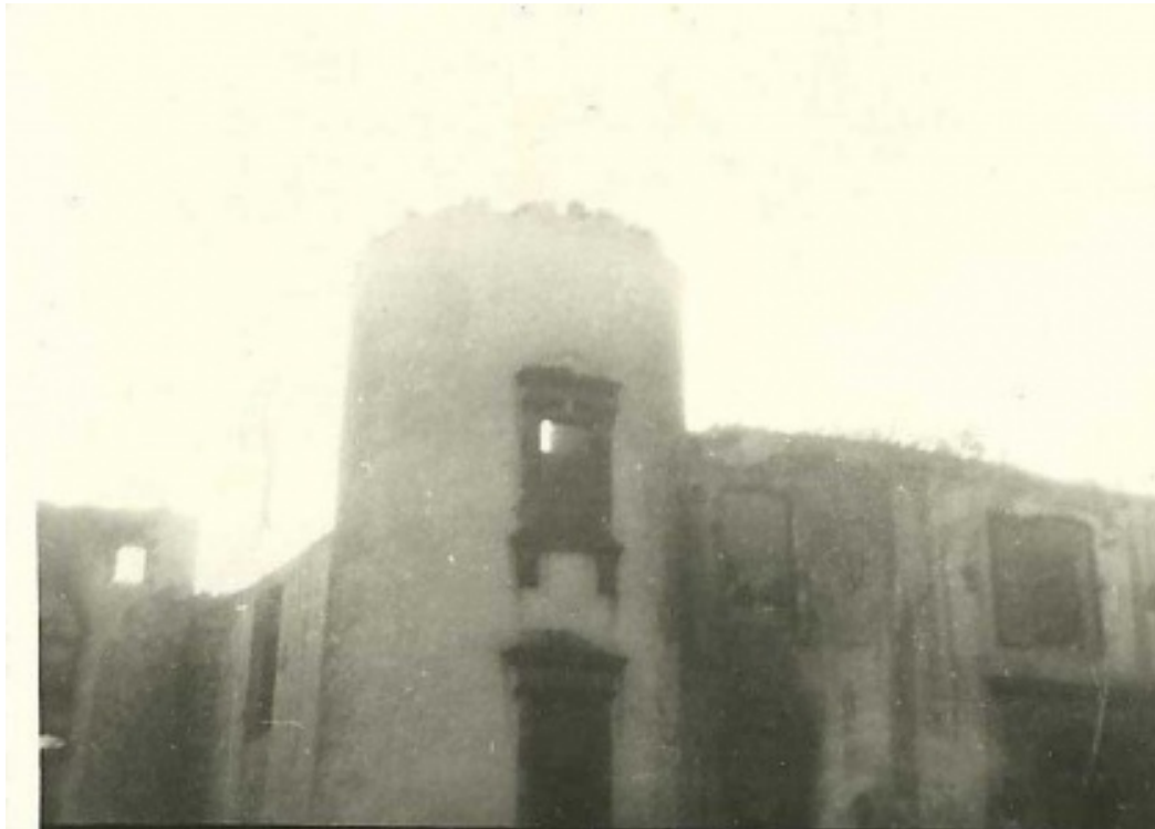
La tour d'angle Sud-Est du château à la fin de l'incendie le 23 juin 1944. Les toitures, charpentes, planchers et ornements intérieurs sont totalement détruits.
