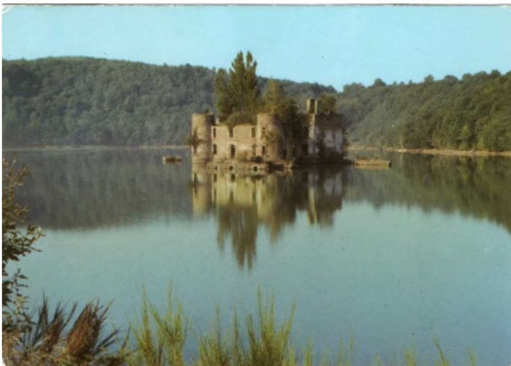
Les ruines du château vues depuis l'Est dans les années 1970. Il s'agit de la dernière photo que nous ayons sur laquelle la façade Est du château est encore debout. La végétation s'étant développée dans le château, la façade Est (façade principale où se trouvait l'entrée et le magnifique perron) et le mur de refend s'effondrent dans les années 1970 ou au début des années 1980.
