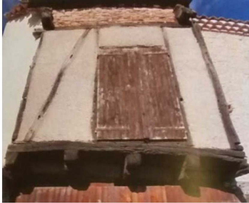
Maison à pans de bois en encorbellement et remplissage en torchis, adossée à la muraille. Façade donnant sur le réduit collectif.
